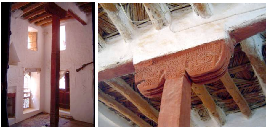
Fig. 6 Interni, in cui si vede la colonna rompi-tratta delle travi portanti dei solai e il 'capitello' di ripartizione dei carichi.
