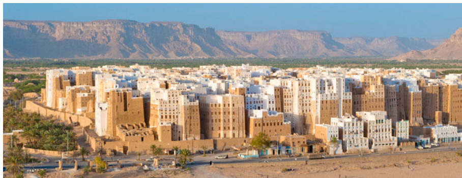
Fig. 1 – Lo skyline di Shibam, un unicum nel panorama della costruzione in terra.
