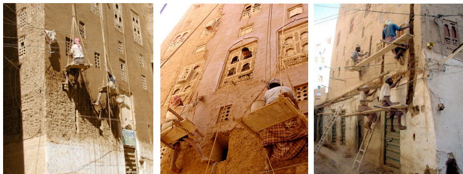
Fig. 7 – Rivestimento delle murature con malta di terra-fango.
